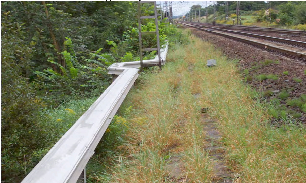
CABSYS RAIL mit vorgefertigten Mastumgehungen
