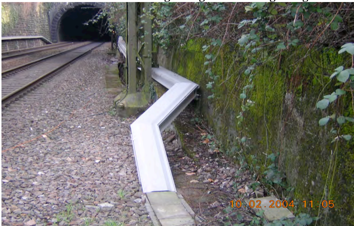
CABSYS RAIL im Tunneleingang (CABSYS RAIL nicht im Tunnel verwenden)
