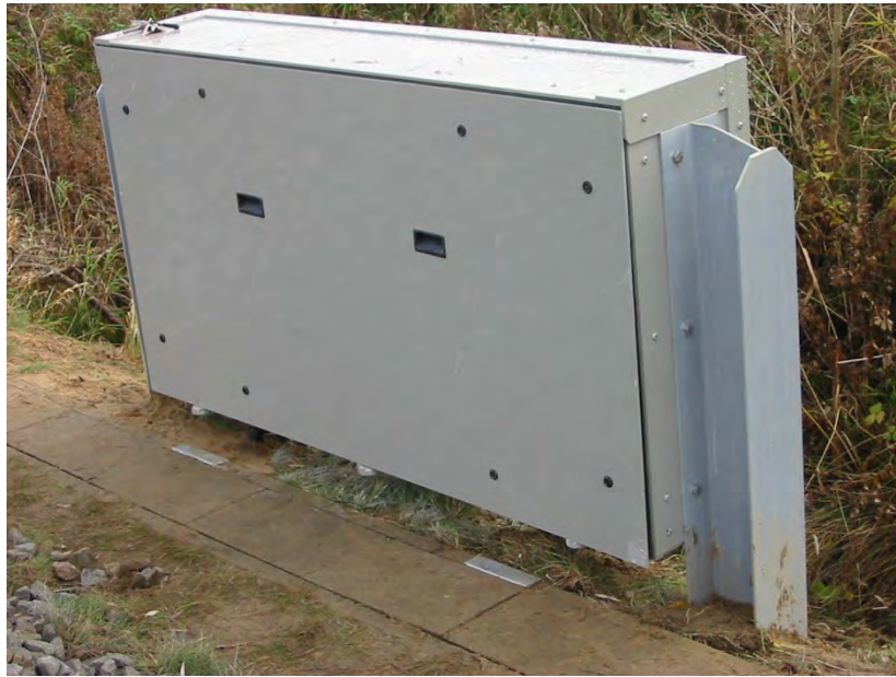
Beispiel: Muffen- und Mehrlängen-Ablage
