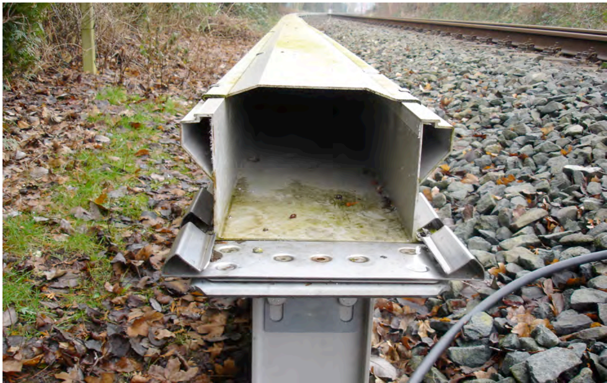
Neues schwimmendes Auflager für CABSYS RAIL
