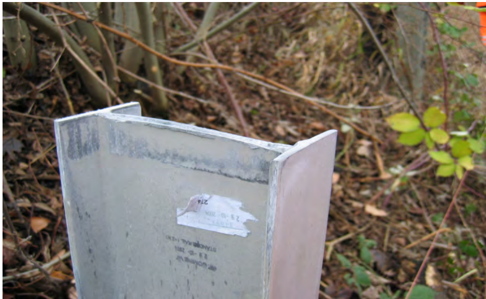
GFK-Ständer nach dem Rammen
